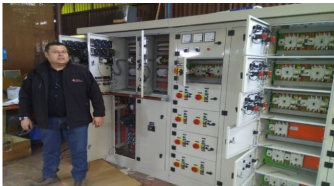
Celdas en Media Tensión tipo NALF en 12 – 17,5 – 24 – 36kV
