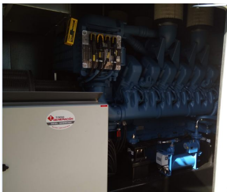
UPS rotatoria con volante de inercia de 1,5 MW c/u, motor MTU.
